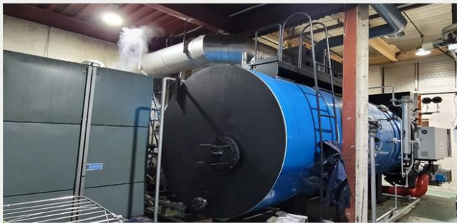
열회수장치 설치 : 폐열을 활용하여 1차 숙성실 운영
